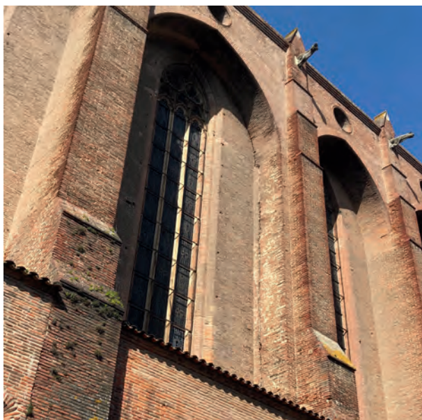
FIG. 4. VUE DE DÉTAIL DE L'ÉLEVATION SUD DE LA NEF. Le « ressaut » de brique sur lequel vient reposer la retombée droite de l'arcature. Cl. B. Sournia.
