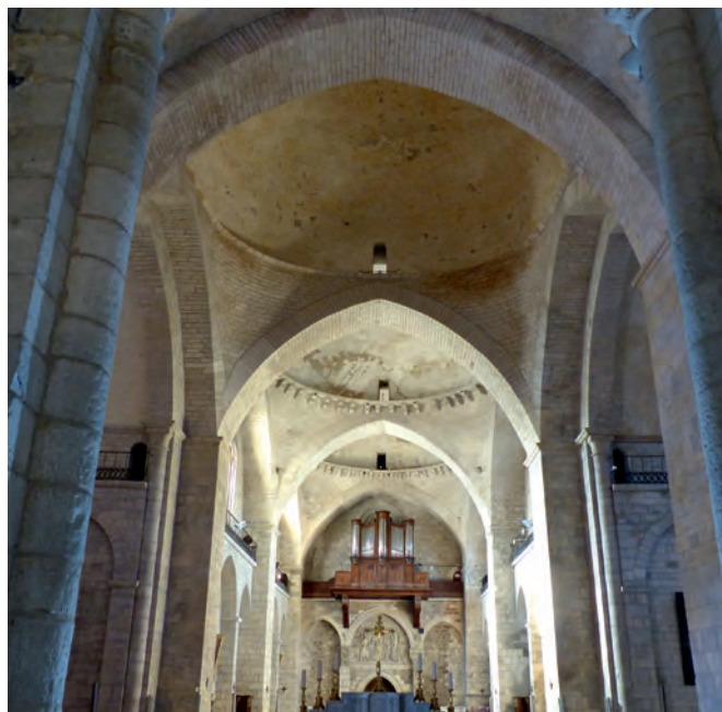
FIG. 19. SOUILLAC, les trois coupoles de la nef, vues depuis le chevet. Cl. G. Séraphin.
