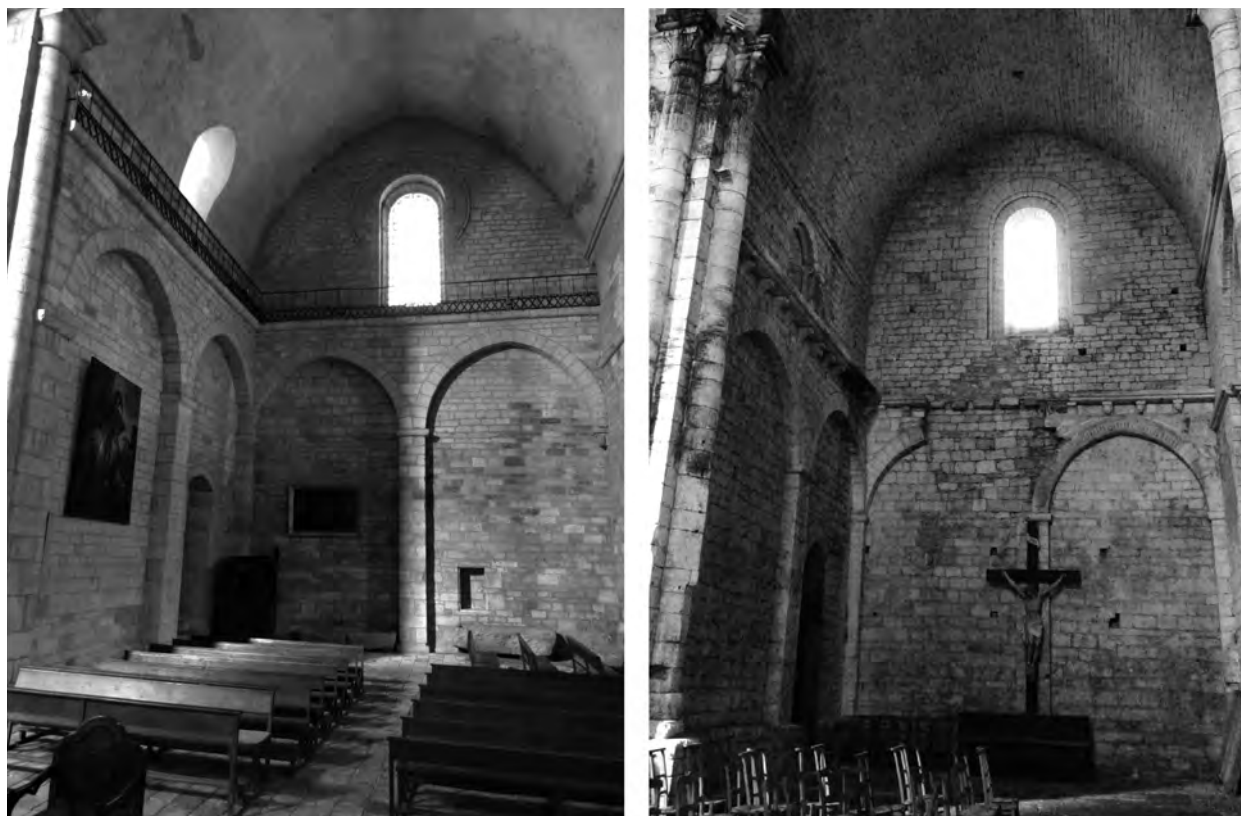
FIG. 15. TRANSEPT À COURSIÈRES SUR ARCATURE D'APPLIQUE. À gauche : Souillac, bras nord. À droite : Saint-Amand-de-Colly, bras nord. Cl. G. Séraphin.
