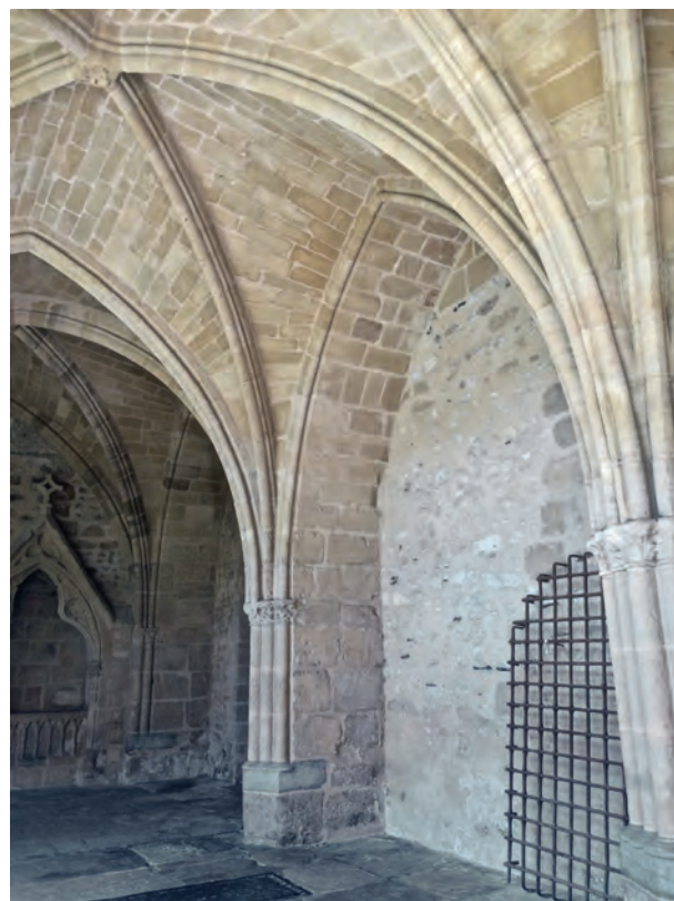
FIG. 32. BERCEAU FORMERET dans la galerie ouest du cloître. Cl. B. Sournia.
