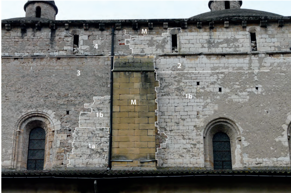
FIG. 9. ÉLÉVATION SUD DE LA NEF, CÔTÉ CLOÎTRE. Phasage simplifié. M : maçonneries postérieures au Moyen Âge. Cl. et analyse de G. Séraphin.
