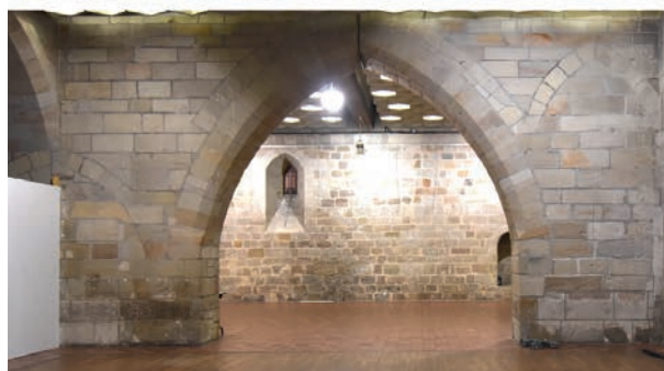
FIG. 19. FAÇADE NORD DE LA COUR (une dalle de béton recouvre actuellement le rez-de-chaussée). Cl. A.-L. Napoléone.
