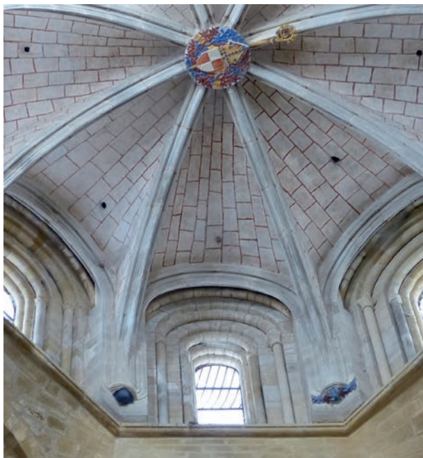
FIG. 8. CONQUES, COUPOLE NERVÉE DE LA TOUR-LANTERNE. Les structures médiévales apparaissent à l'arrière des apports de la fin du XV e siècle. Cl. G. Séraphin.
