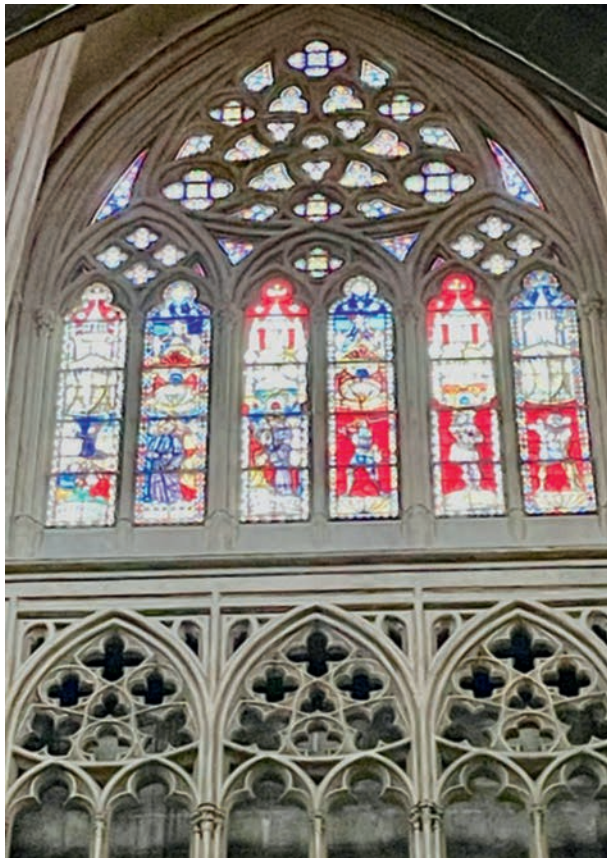
FIG. 23. FENÊTRE SUD DE LA TRAVÉE numéro 3. Cl. B. Sournia.
