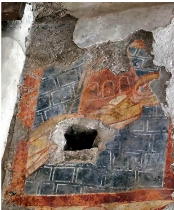
FIG. 15. CHŒUR, MUR SUD. Cl. G. Vivier, 2022.
