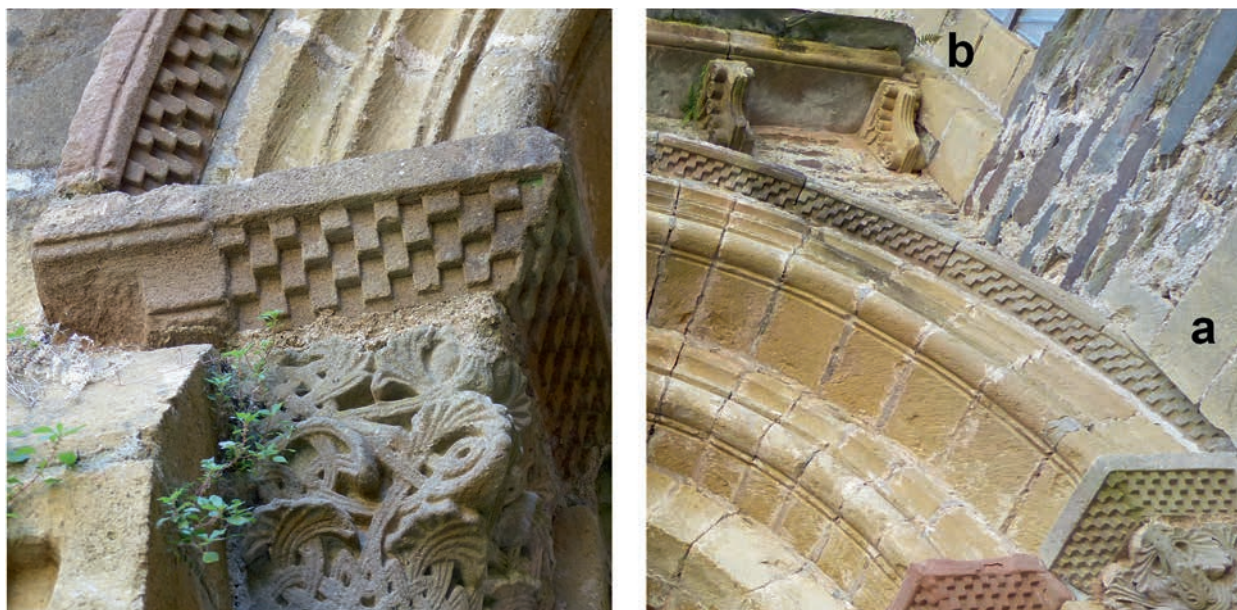
FIG. 13. CONQUES, DÉTAILS DU PORTAIL NORD DU TRANSEPT. À gauche : damier retaillé dans un tailloir en cavet remployé. À droite : retombée de l'archivolte. a : discordance entre l'archivolte et le parement de la nef. b : accollement de la corniche contre le tableau de la fenêtre. Cl. G. Séraphin.
