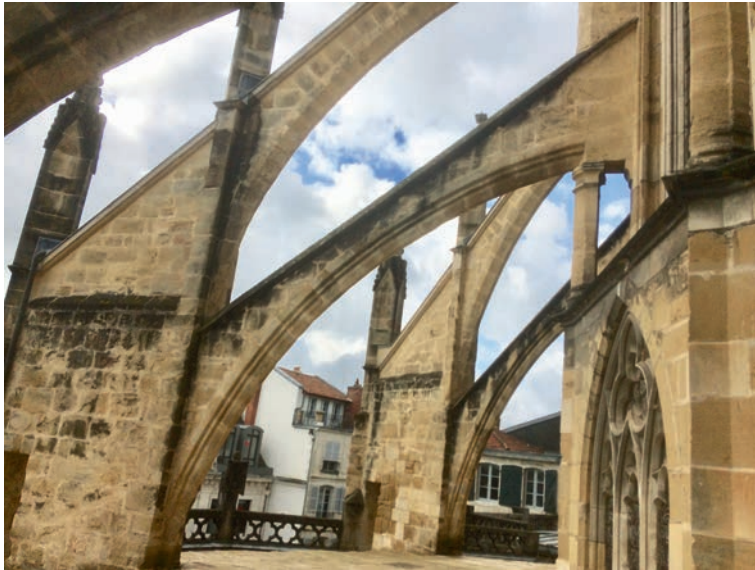
FIG. 7. ARCS BOUTANTS DOUBLES DE L'ABSIDE. Cl. B. Sournia.
