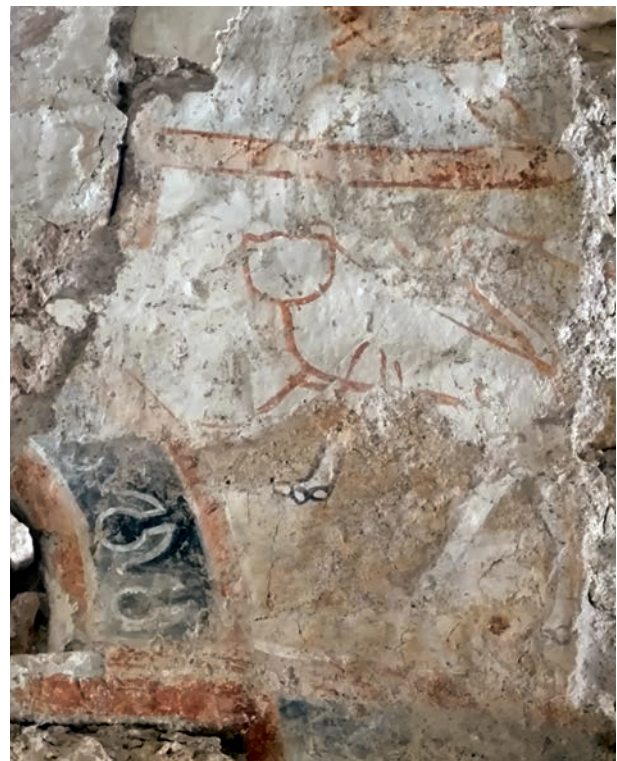
FIG. 20. CHŒUR, MUR SUD. Cl. G. Vivier, 2022.
