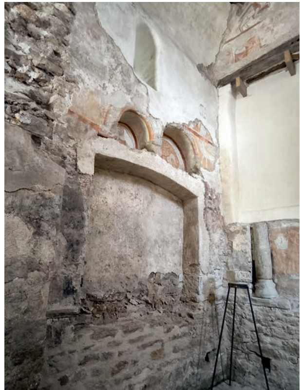
FIG. 17. CHŒUR, MUR NORD. Cl. G. Vivier, 2022.
