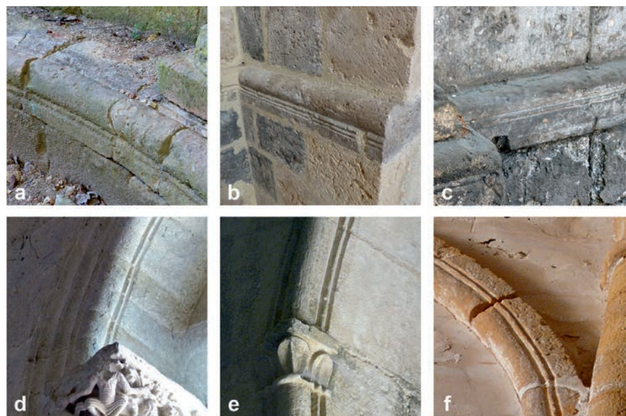
FIG. 20. MOULURE TORIQUE DÉGAGÉE PAR UNE BAGUETTE ANGULEUSE.
