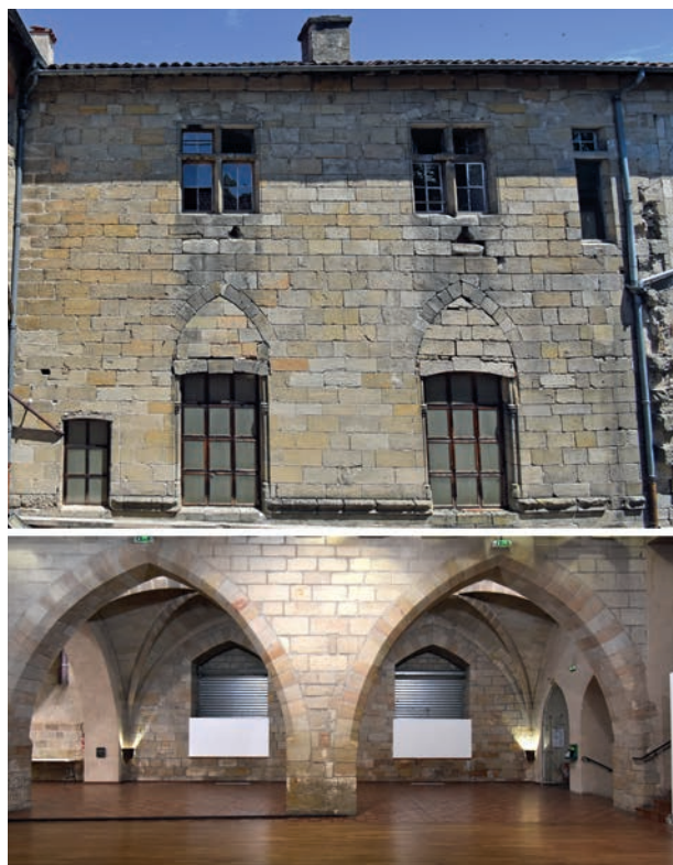
FIG. 18. FAÇADE EST DE LA COUR (une dalle de béton recouvre actuellement le rez-de-chaussée). Cl. A.-L. Napoléone.
