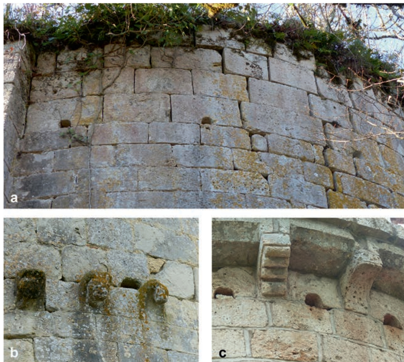
FIG. 15. DALLES PERCÉES ET MÉTOPES PERFORÉES EN DEMI-LUNE. a : Pestilhac, élévation nord-est du chevet. b : Saint-Ferme, absidiole nord. c : Engayrac, corniche de l'abside. Cl. G. Séraphin.
