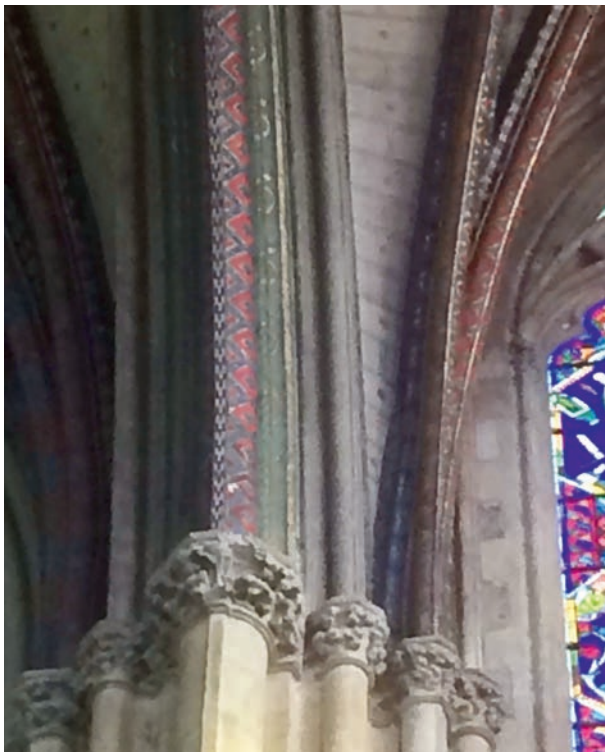
FIG. 8. ARC DIAGONAL (bleu) pénétrant un arc doubleau (rouge) à la limite entre le chœur et le transept. Cl. B. Sournia.
