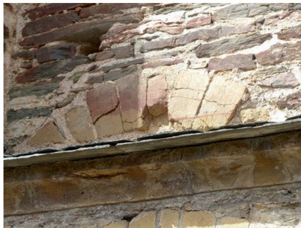
FIG. 15. CONQUES, BAS-CÔTÉ SUD. Vestiges des claveaux (rubéfiés et éclatés ?) d'une porte condamnée au-dessus de l'enfeu de l'abbé Bégon. Cl. G. Séraphin.
