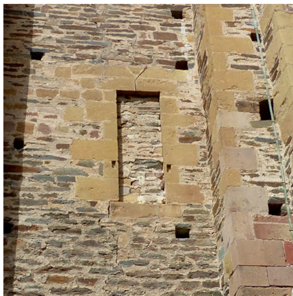
FIG. 38. CONQUES, ÉLEVATION SUD DE LA TOUR SUD. Porte haute murée surmontant deux trous d'encastrement (dont un condamné). Cette porte, à distance des bâtiments conventuels, ne pouvait donc pas communiquer directement avec eux. Cl. G. Séraphin.
