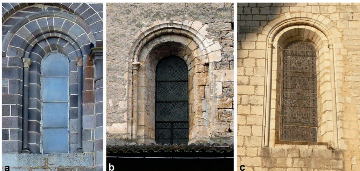
FIG. 3. FENÊTRES LIMOUSINES encadrées par une moulure creuse.
