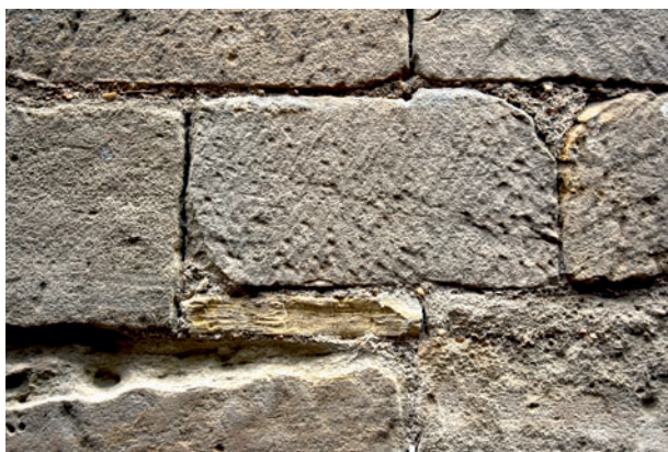
FIG. 13. TRACES DE TAILLE À LA BRETTURE SUR UN BLOC DE LA FAÇADE NORD. Cl. A.-L. Napoléone.
