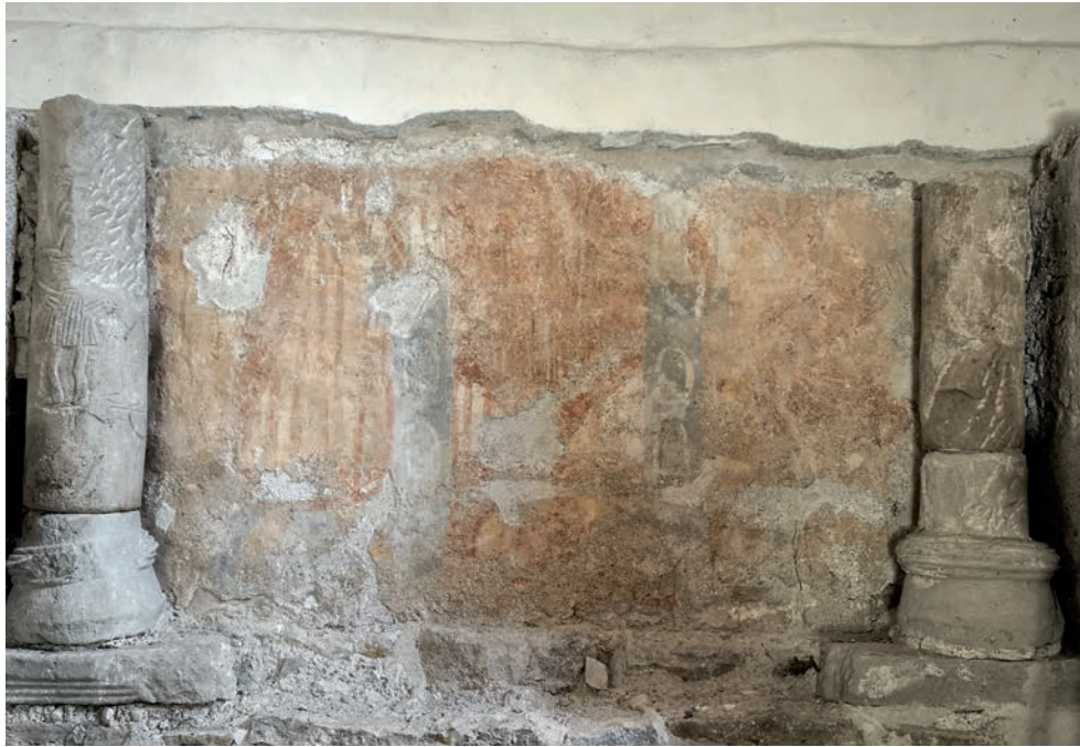
FIG. 14. CHEUR, MUR EST, Cl. G. Vivier, 2022.
