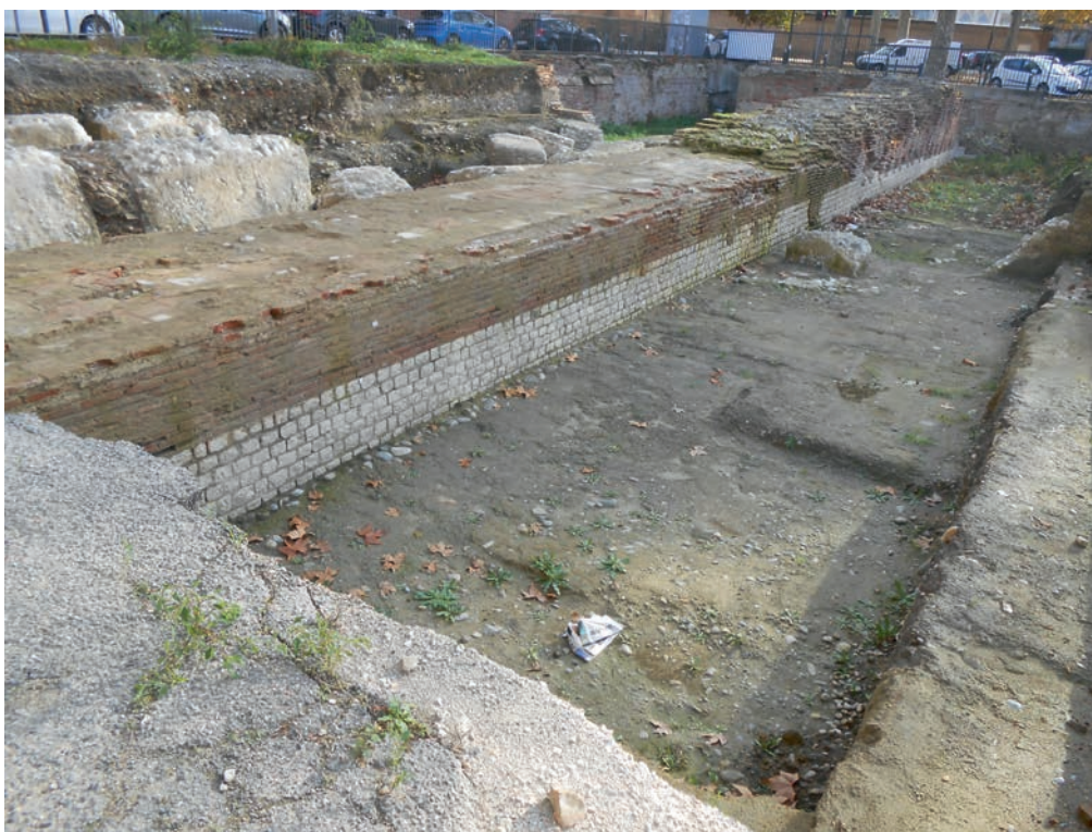
TOULOUSE. RUE BIDA ET PLACE SAINT-JACQUES. Base du rempart romain dégagée en 1973 et 2022. Vue extérieure montrant des blocs de maçonnerie basculés extra muros. Cl. P. Cabau 11-12-2022.
