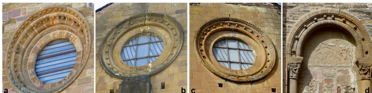
FIG. 37. CONQUES : THÈME DES MOULURES CREUSES ANIMÉES PAR DES MACARONS POLYGAONAUX OU PAR DES BOULES. a : pignon de la façade occidentale. b : pignon du bras nord du transept. c : pignon du bras sud du transept. d : porte de l'élévation sud de la tour sud. Cl. G. Séraphin.
