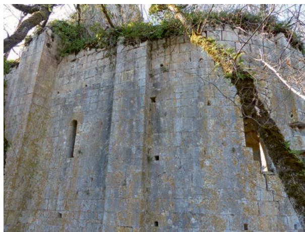
FIG. 5. PESTILHAC, chapelle castrale. Élévation nord-est du chevet. Cl. G. Séraphin.
