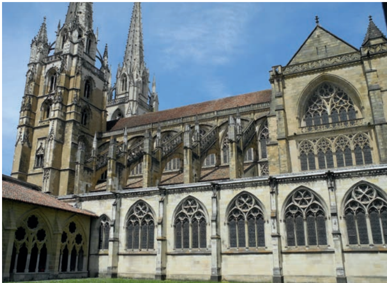
FIG. 19. FACE SUD DE LA CATHÉDRALE : le niveau bas correspond à la chapelle paroissiale et à la sacristie édifiées par Boeswillwald en lieu et place de la galerie nord du cloître. Cl. B. Sournia.
