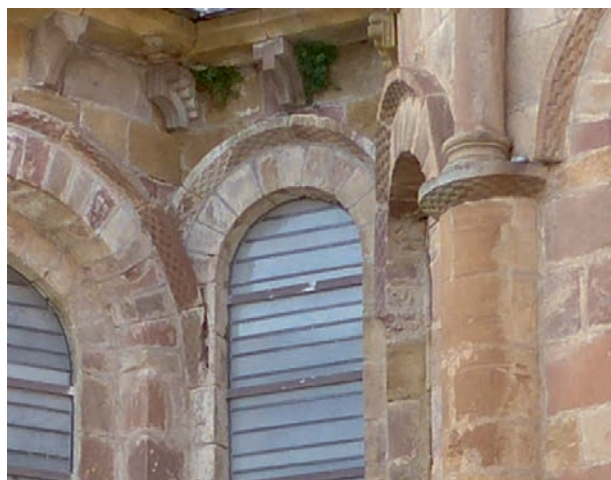
FIG. 4. CONQUES, DÉTAIL DE L'ORDONNANCEMENT DU CHEVET montrant les défauts de raccordement des archivoltes. Cl. G. Séraphin.
