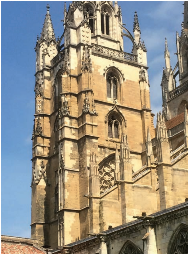
FIG. 40. CLOCHER SUD La teinte blanche du calcaire de Crazannes marque les réfections de Boeswillwald. Cl. B. Sournia.
