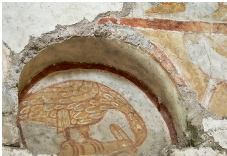
FIG. 18. CHEUR, MUR NORD. Cl. G. Vivier, 2022.
