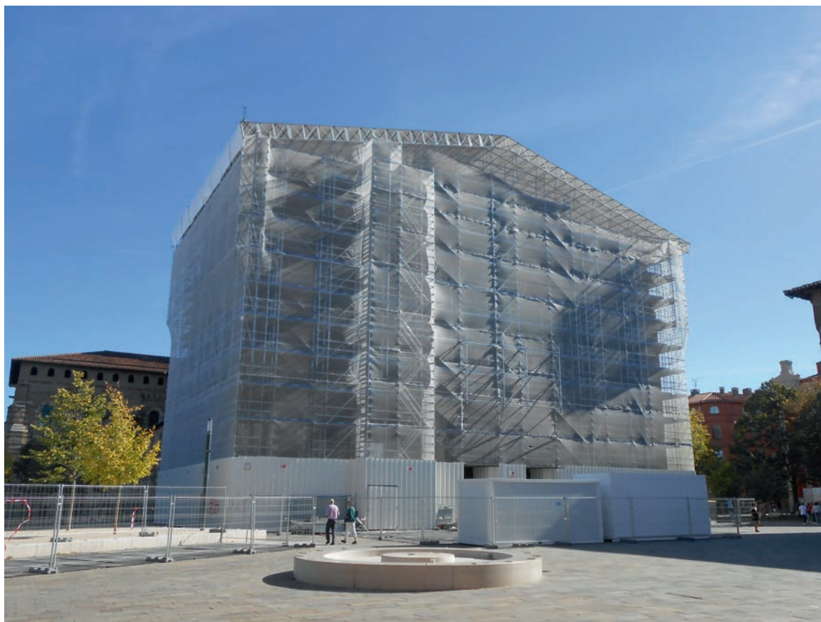
TOULOUSE SAINT-SERNIN. Massif occidental de la basilique échafaudé et « emballé » pour travaux. Cl. P. Cabau 15-10-2022.
