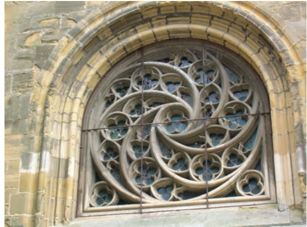
FIG. 28. FENÊTRE EN FORME DE ROSACE de la première travée, collatéral sud. Cl. B. Sournia.
