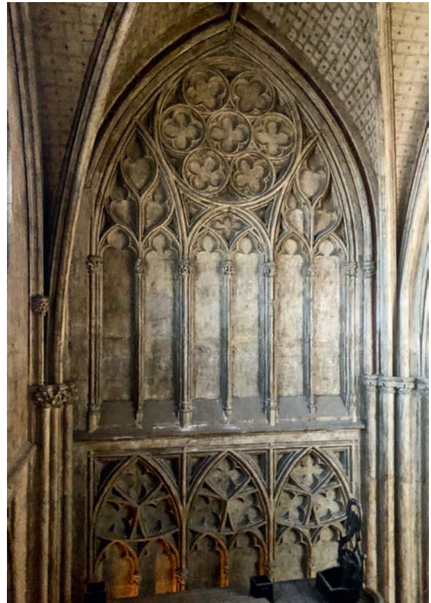
FIG. 32. FENÊTRE ET TRIFORIUM EN ORBEVOIE de la première travée, côté sud. Cl. B. Sournia.
