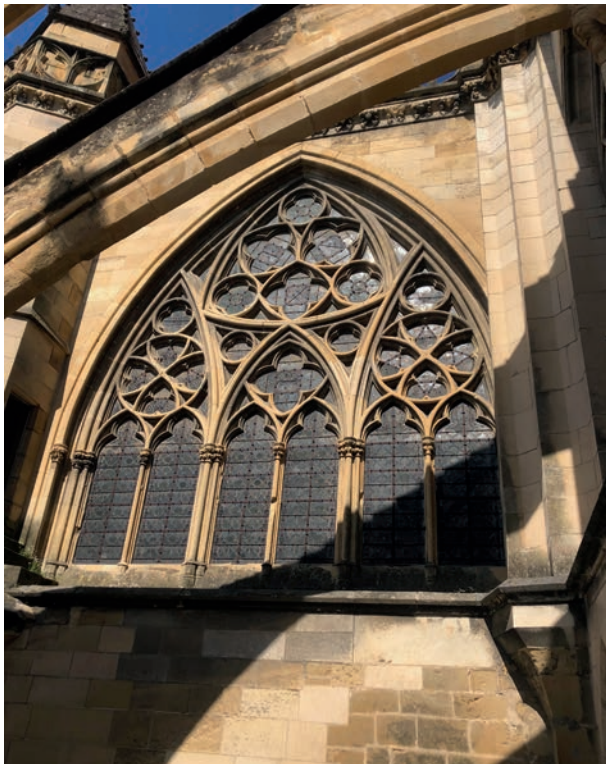
FIG. 12. FENÊTRE DANS LE CROISILLON NORD DU TRANSEPT regardant à l'Ouest. Cl. B. Sournia.
