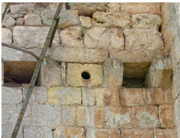
FIG. 2. SÉGOS (commune de Bélaise, Lot), élévation nord du chevet. Métopes perforées placées en fermeture de niches à volatiles.
