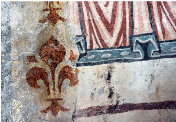
FIG. 7 : DÉTAIL DU BANDEAU FLEURDELISÉ côté nord et de la couverture de Marie dans la scène de la Nativité. On remarque la restauration au tratteggio . Cl. E. Garland, août 2021.
