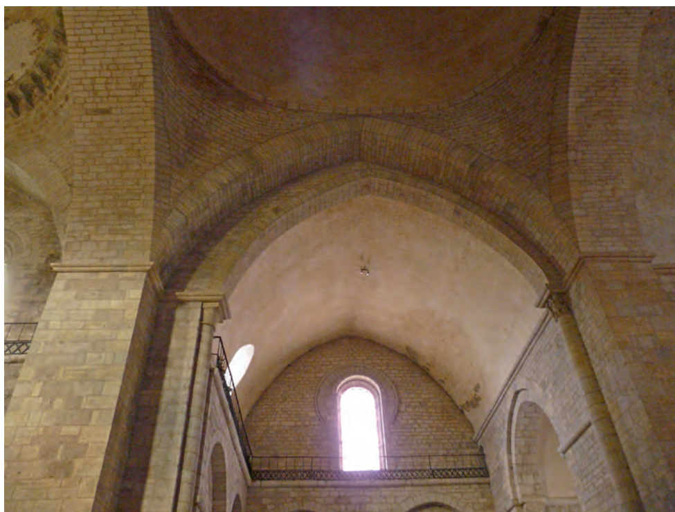
FIG. 8. BRAS NORD DU TRANSEPT. Noter le décentrement de l'arc porteur de la coupole par rapport au doubleau d'entrée du bras de transept. Les impostes sont en double quart de rond sans réglet. Cl. G. Séraphin.
