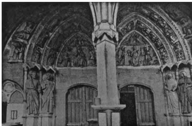
FIG. 25. PORTAIL DOUBLE du croisillon méridional. La pile médiane résulte des restaurations de Boeswillwald au XIX e siècle, mais le principe de ce support axial reproduit la configuration d'origine. Cl. É. Lambert.
