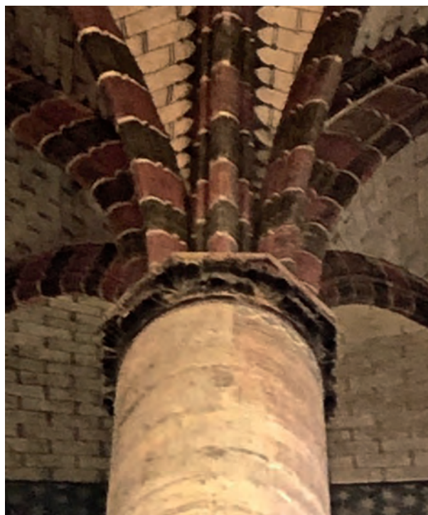
FIG. 13. LA DERNIÈRE PILE DU CHŒUR AU CONTACT DE LA NEF. La petite frise peinte de quadrilobes, sous l'astragale du chapiteau, s'interrompt tout net à la moitié du tambour à la distance de cinquante centimètres environ de la cloison supposée : ce détail semble attester que la campagne de décor peint (sûrement amorcée dans le chœur juste avant la consécration de 1292 en mettant à profit les échafaudages encore en place de la construction) s'est arrêtée au moment d'arriver au contact de la cloison. Il semble que cette observation de Hortense Rolland donne une sérieuse crédibilité à l'hypothèse qui fait l'objet de la présente communication. Cl. B. Sournia.
