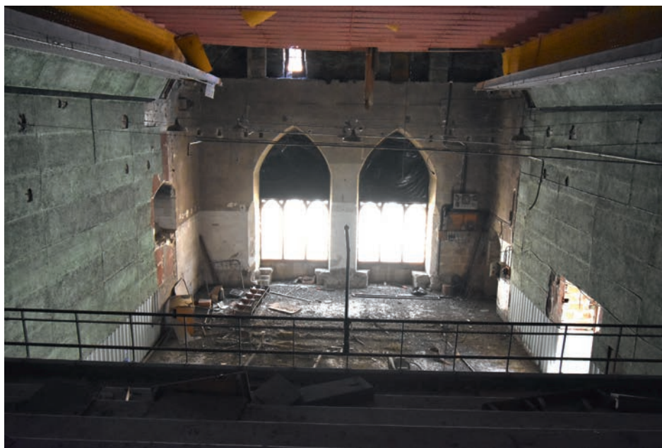
FIG. 27. VUE DE L'aula DANS SON ÉTAT ACTUEL (vue vers l'Est). Cl. A.-L. Napoléone.
