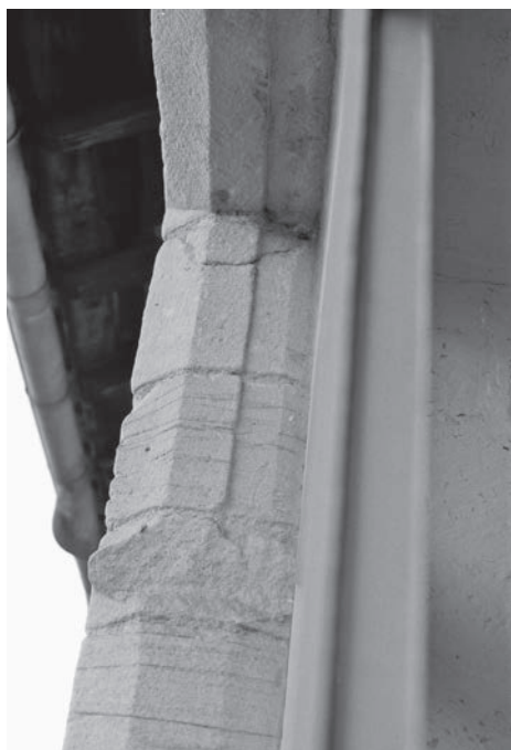
FIG. 30. PIÈCE DU SECOND ÉTAGE DE L'AILE EST : détail de la partie supérieure de la croisée donnant sur la rue Balène. Feuillure destinée à recevoir le châssis garni de verre ou de papier huilé.
