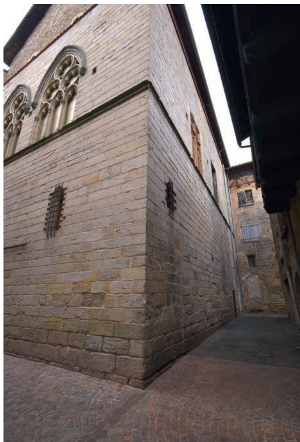
FIG. 12. FAÇADE NORD DU PALAIS sur l'impasse Balène. Dans le fond, un bâtiment qui a pu constituer une dépendance du palais. Cl. A.-L. Napoléone.
