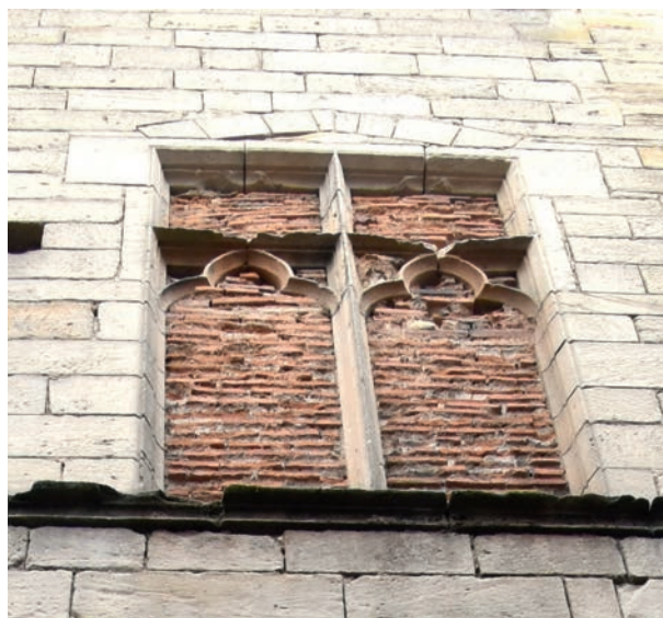
FIG. 14. PREMIÈRE CROISÉE À RÉSEAUX CONSERVÉE SUR LA FAÇADE NORD. Cl. A.-L. Napoléone.
