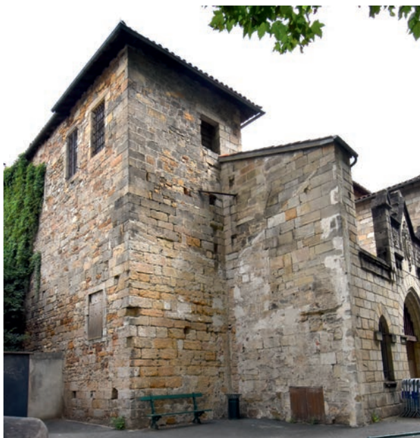
FIG. 15. ANGLE SUD-OUEST DU PALAIS où se trouvaient deux niveaux de latrines abattues lors des travaux de 1828-1832. Cl. A.-L. Napoléone.
