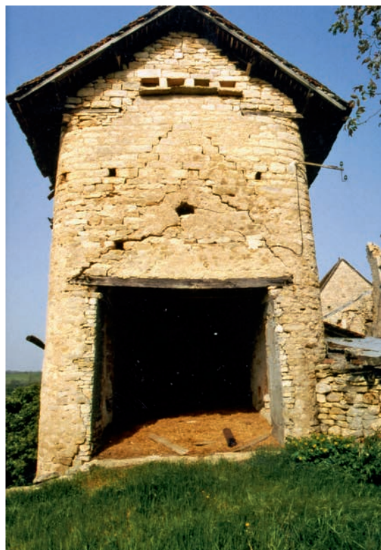
FIG. 3. LE CHEVET AVANT LA SUPPRESSION DE LA RAMPE TALUTÉE. UDAP 12, non datée, avant 1993. Cl. Dominique Larpin. Paru dans « Au sujet de Toulongergues. Il faut sauver "l'écrin et le bijou" », Centre Presse , Louis Balsan.
