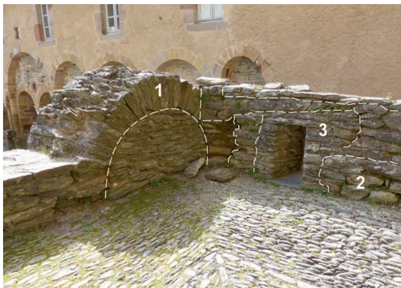
FIG. 21. CONQUES, VESTIGES DE L'ANCIENNE PORTE D'ACCÈS AU CLOÎTRE depuis la rampe adossée au bras sud du transept. Cl. G. Séraphin.
