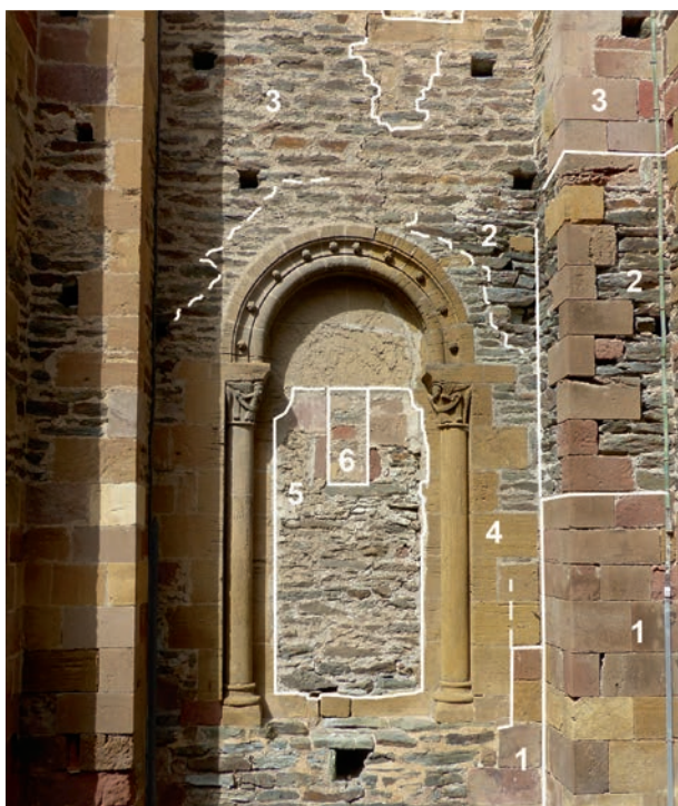
FIG. 17. CONQUES, ÉLÉVATION SUD DE LA TOUR MÉRIDIONALE. Esquisse de chronologie relative. Porte replacée dans les traces d'une baie antérieure. Cl. et analyse G. Séraphin.
