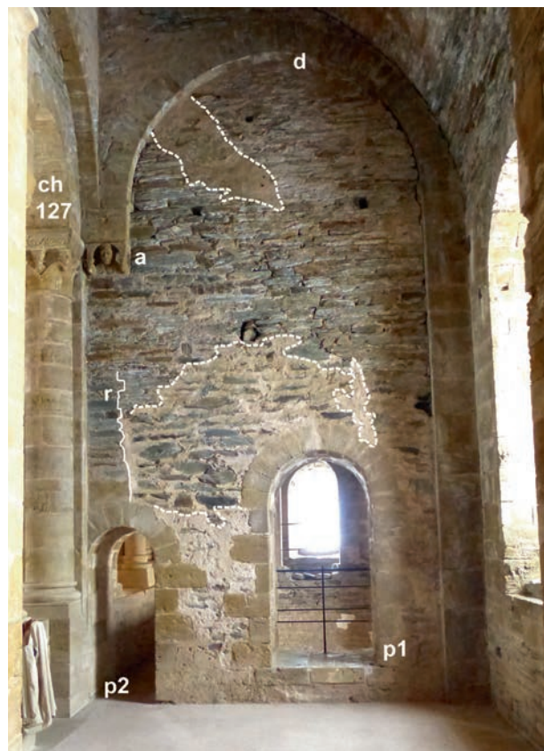
FIG. 33. CONQUES, TOUR NORD-OUEST, élévation est, côté tribune latérale. a : atlante. ch 127 : chapiteau n° 127. d : arc de décharge non traversant. p1 : passage. p2 : porte d'accès à la passerelle formant fausse tribune. r : reprise de parement en saignée pour la mise en place de la colonne engagée et de la porte p2 . Cl. G. Séraphin.
