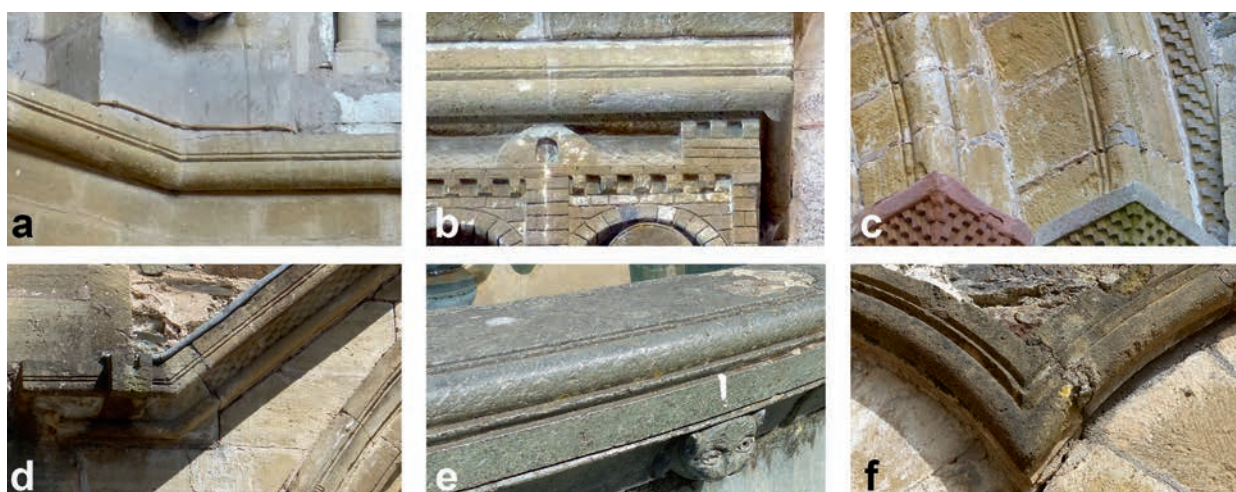
FIG. 10. CONQUES, MOULURE TORIQUE DÉGAGÉE PAR UN FILET ANGULEUX. a : cordon d'appui de la tour-lanterne. b : couronnement du relief de l'Annonciation. c : portail nord du transept. d : couronnement du grand portail occidental. e : margelle du bassin claustral. f : archivolte de l'arcature orientale du cloître. Cl. G. Séraphin.
