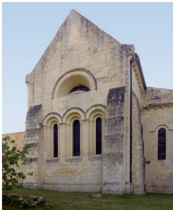
FIG. 22. PLEINE-SELVE (Gironde) chevet quadrangulaire de l'église abbatiale percé d'un triplet avec archivoltas à gaufres étoilées, surmonté d'une baie en demi-lune. Cl. G. Séraphin.
