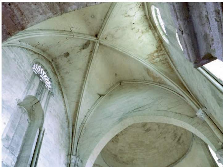
FIG. 21. COLLÉGIALE DE SAINT-ÉMILION, vue de la première travée de la nef et coupole de la deuxième travée. Les fenêtres en demi-lune ornées de gaufres étoilées sont percées sous les arcs formerets des élévations latérales nord et sud. Cl. G. Séraphin.
