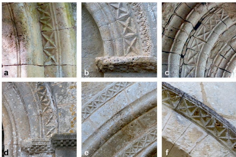
FIG. 19. ARCHIVOLTES ORNÉES DE GAUFRES ÉTOILÉES. a : Pestilhac, portail nord. b : Valeilles (Tarn-et-Garonne), portail sud. c : Vitrac (Laroque-Timbault, Lot-et-Garonne), vestiges du portail. d : Cassagnes (Lot), portail sud. e : Saint-Émilien (Gironde), ancienne collégiale, fenêtre nord de la première travée de nef. f : Pleine-Selve (Gironde), chevet de l'ancienne abbatale, fenêtre du triplet occidental. Cl. G. Séraphin.
