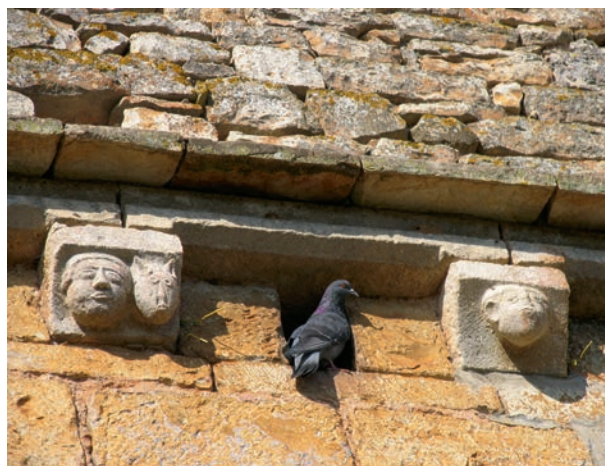
FIG. 3. CANOURGUE (Commune des Junies, Lot), élévation est du chevet. Niches de pigeons intercalées entre les modillons.
