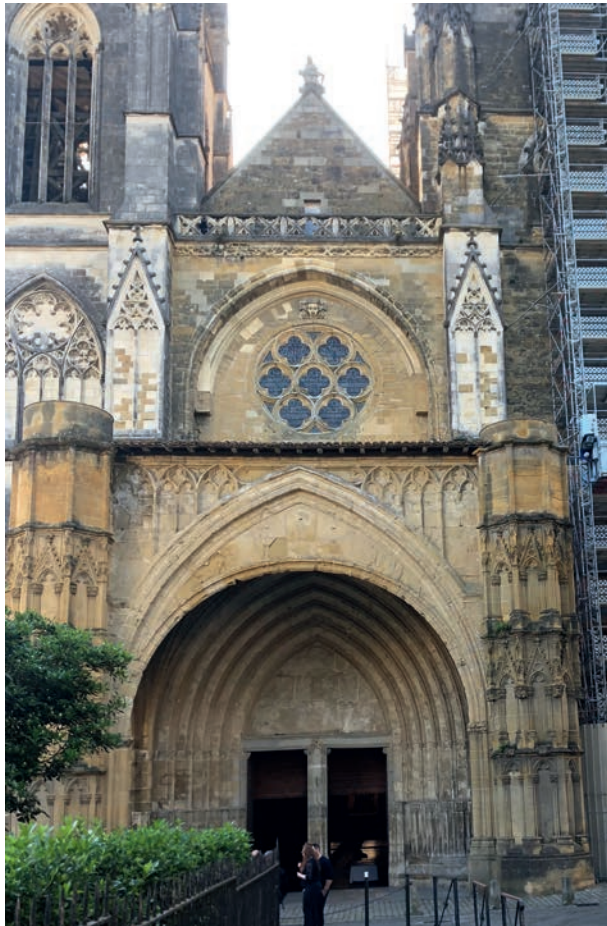
FIG. 37. PORCHE ANTÉRIEUR. Noter les deux arcs « emboîtés » du porche en plein cintre et en arc brisé ; la rosace dans l'axe de laquelle figurent les armes royales de France ; et noter enfin la teinte blanche du calcaire de Crazannes signant les réfections de Boeswillwald.
