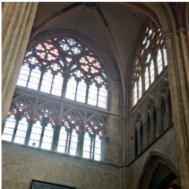
FIG. 43. FENESTRAGE DU CROISSILLON NORD DU TRANSEPT, vue intérieure. Cl. B. Sournia.
