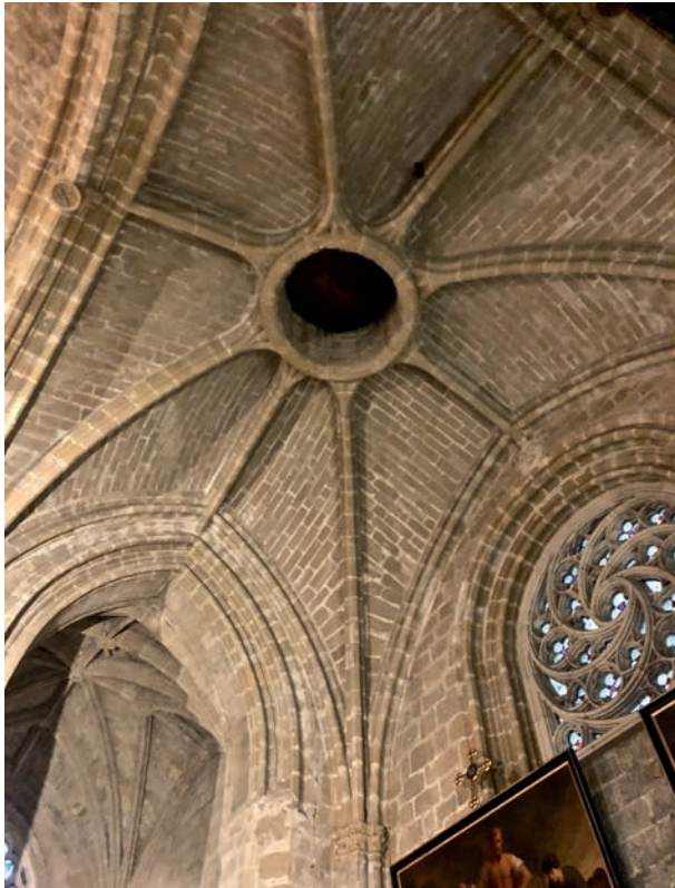
FIG. 27. VOÛTE DE LA PREMIÈRE TRAVÉE, collatéral sud. Cl. B. Sournia.
