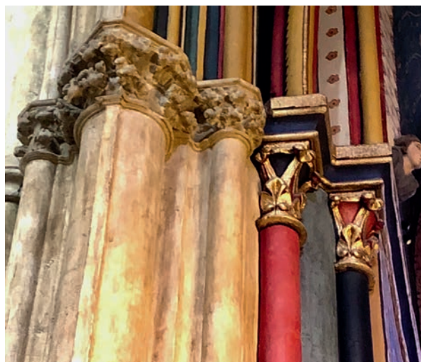
FIG. 6. CHAPITEAUX dans la travée droite du déambulatoire, côté nord, marquant le point de suture entre la première et la seconde campagne des travaux. La polychromie est l'ouvrage conjoint de Boeswillwald et du peintre décorateur Steinheil. Cl. B. Sournia.
