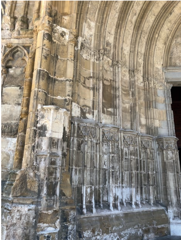
FIG. 25. LE PORTAIL : ébrasement gauche. Le dernier piédestal à gauche a d'abord été arraché à son alignement d'origine, puis « recollé » contre la pile porteuse du porche. Au moment de cette réfection a été sculpté, en style flamboyant, un nouveau chapéron à la partie supérieure du piédestal, dont le matériau, de teinte plus claire, se distingue du reste du piédestal. Cl. B. Sournia.
