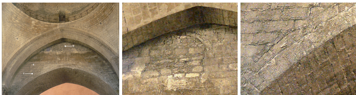
FIG. 3. PÉRIGUEUX, ANCIENNE CATHÉDRALE SAINT-ÉTIENNE de la Cité. Élévation est de la première travée à la jonction de la travée de chœur. a : parement appareillé ; b : traces d'un ancien oculus percé au-dessus de la voûte de l'abside primitive ; c : traces d'arrachement de la demi-coupole de l'abside primitive. Cl. G. Séraphin
