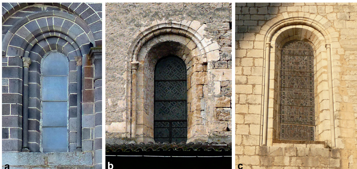
FIG. 3. FENÊTRES LIMOUSINES encadrées par une moulure creuse.
