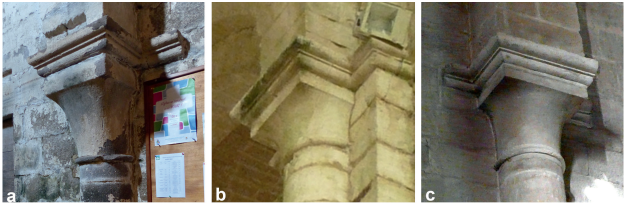
FIG. 5. CHAPITEAUX LISSES À CORBEILLE ÉVASÉE et tailloir à double quart de rond et réglet. a : Herment ; b : Saint-Amand-de-Coly ; c : Obazine. Cl. G. Séraphin.
