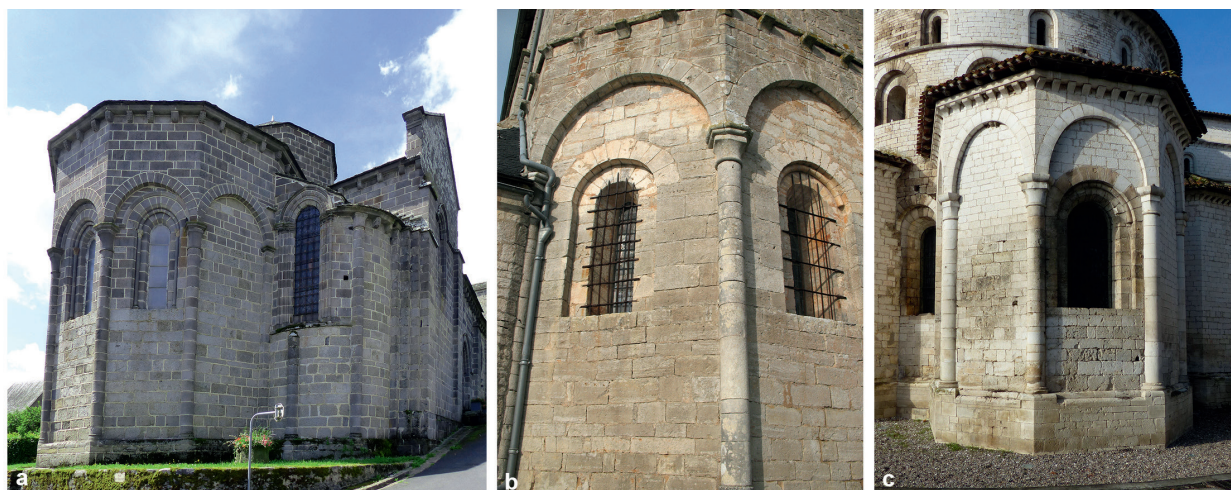
FIG. 2. CHEVETS POLYGONAUX à arcature d'applique portée par des demi-colonnes engagées.
