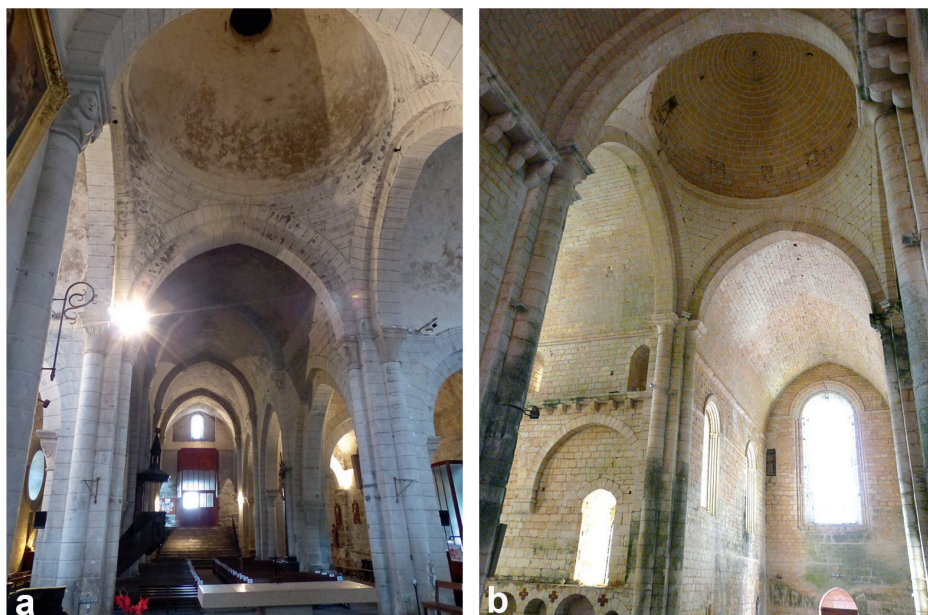
FIG. 4. CROISÉE DE TRANSEPT couverte par une coupole sur pendentifs. a : Herment ; b : Saint-Amand-de-Coly. Cl. G. Séraphin
