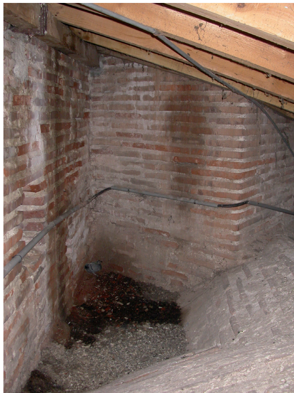
FIG. 3 : COMBLES NORD DE L'ÉGLISE, maçonnerie du contrefort biais de l'abside plaqué sur le mur de l'église et reposant sur la voûte de la chapelle Saint-Pierre. Cl. J. Dubois.
