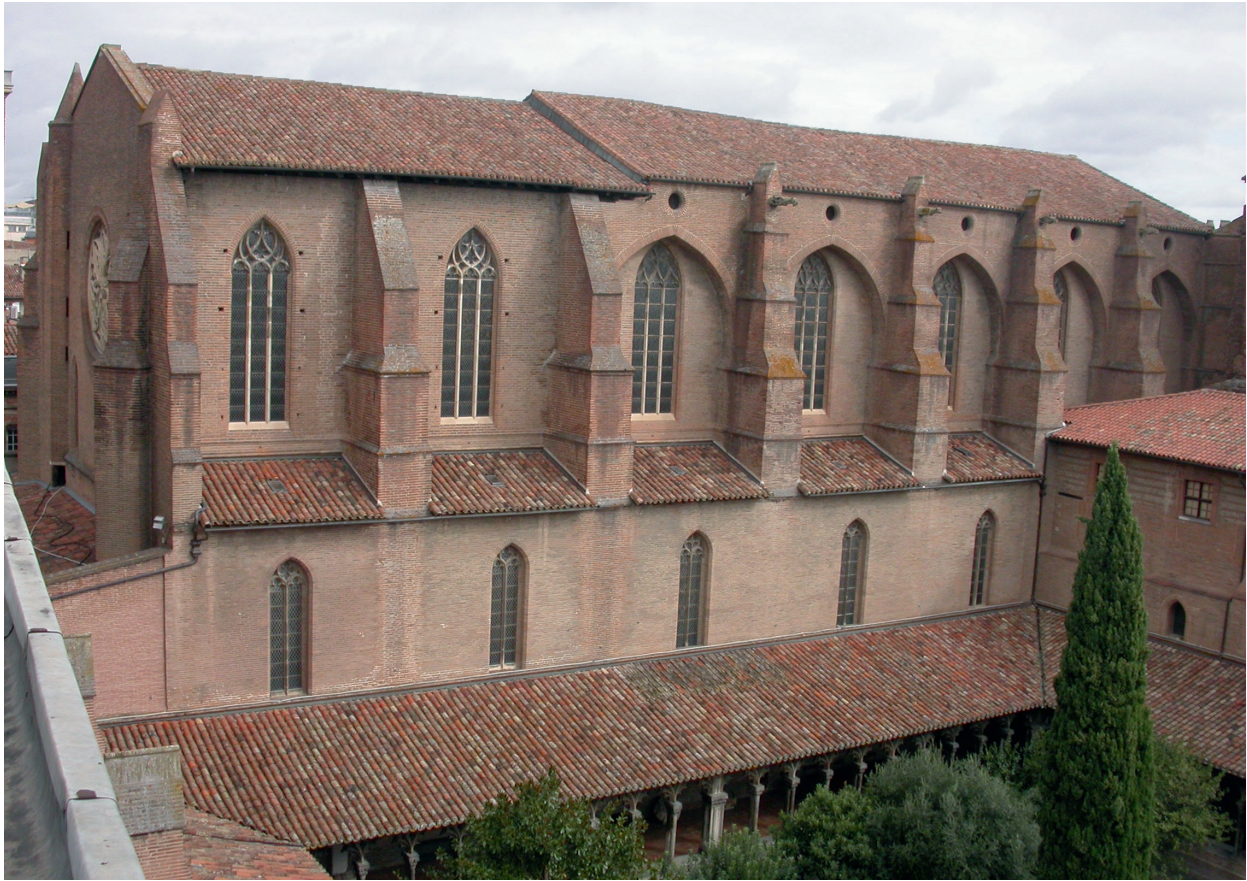
FIG. 2 : VUE GÉNÉRALE DU MUR SUD DE L'ÉGLISE, différence de traitement des deux premières travées. Cl. J. Dubois.
