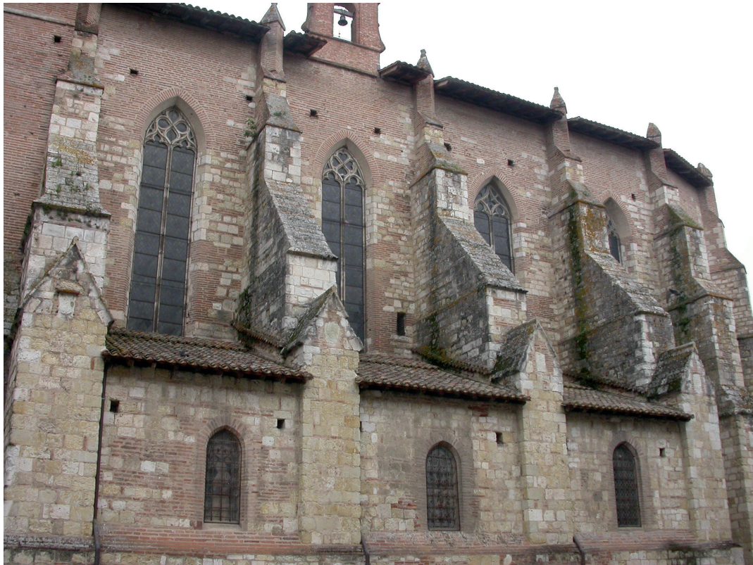
FIG. 4 : VUE EXTÉRIEURE DU CHEVET, mur sud. Cl. J. Dubois.
