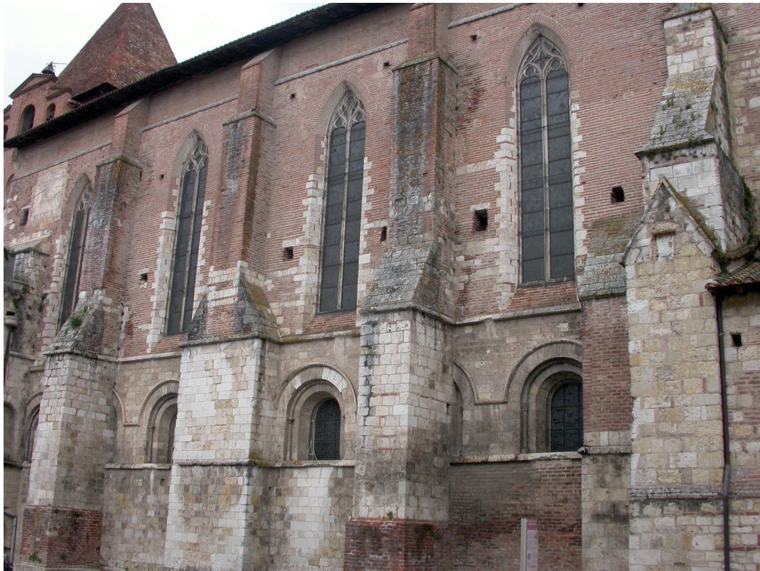
FIG. 2 : VUE EXTÉRIEURE DE LA NEF, mur sud. Cl. J. Dubois.
